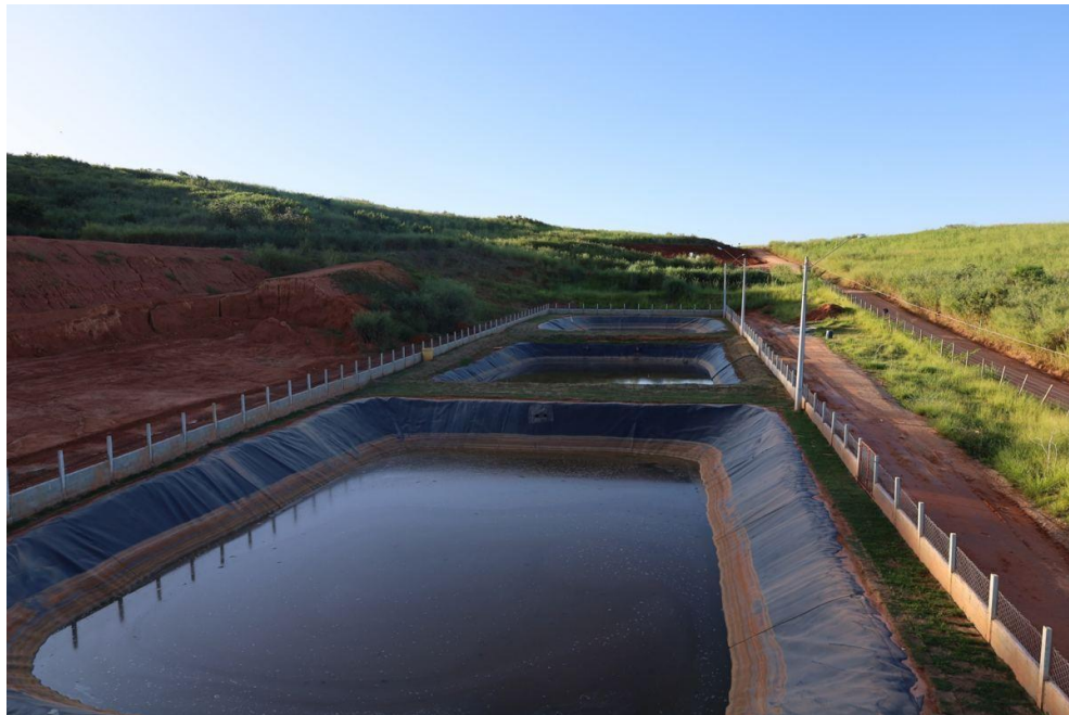
Figura 12. Lagoas de coleta de chorume/lixiviado para tratamento.
