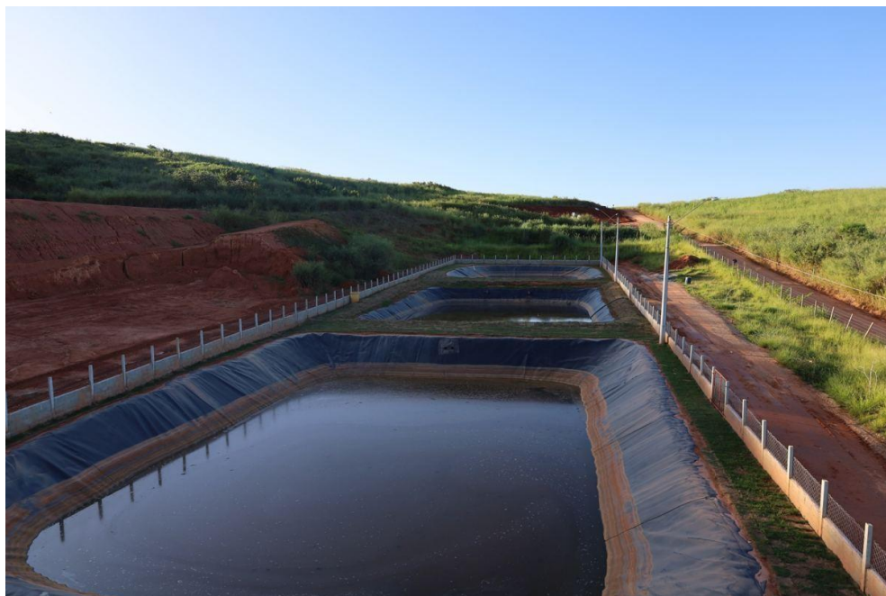
Figura 12. Lagoas de coleta de chorume/lixiviado para tratamento.
