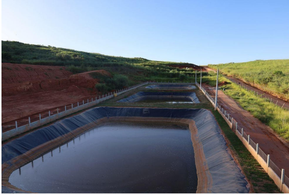
Figura 12. Lagoas de coleta de chorume/lixiviado para tratamento.
